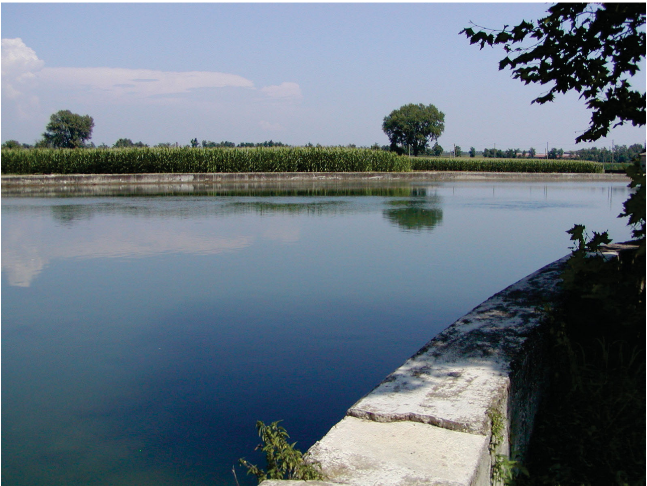
Cividate al Piano-sbarramento del fiume Oglio
