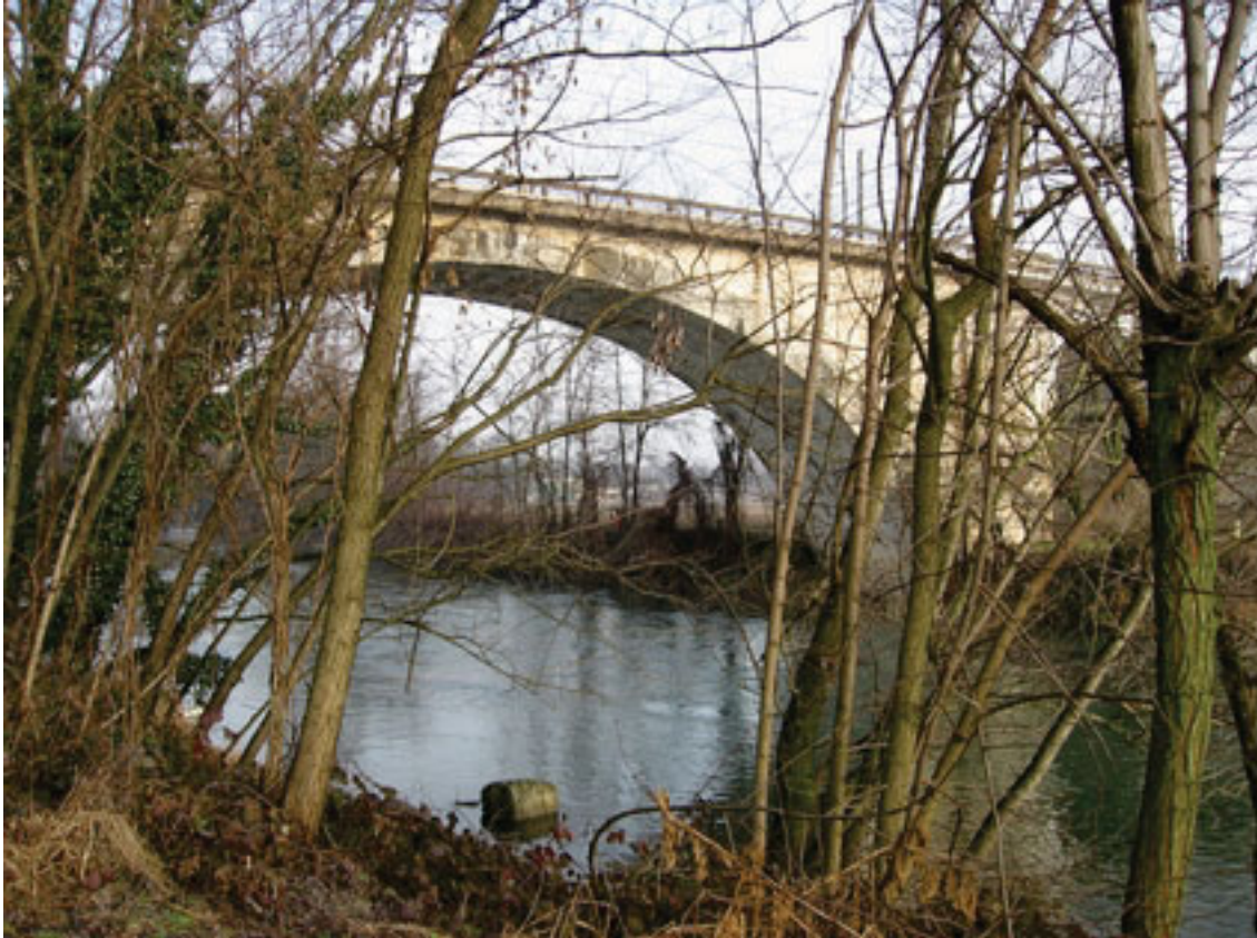
Il ponte della ferrovia MI-VE
