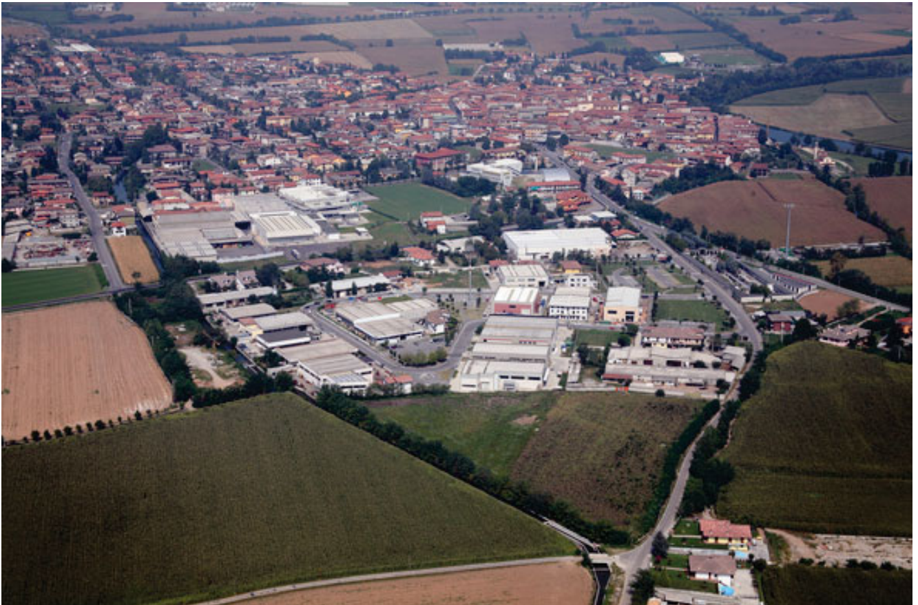
Veduta Aerea - Zona Artigianale
