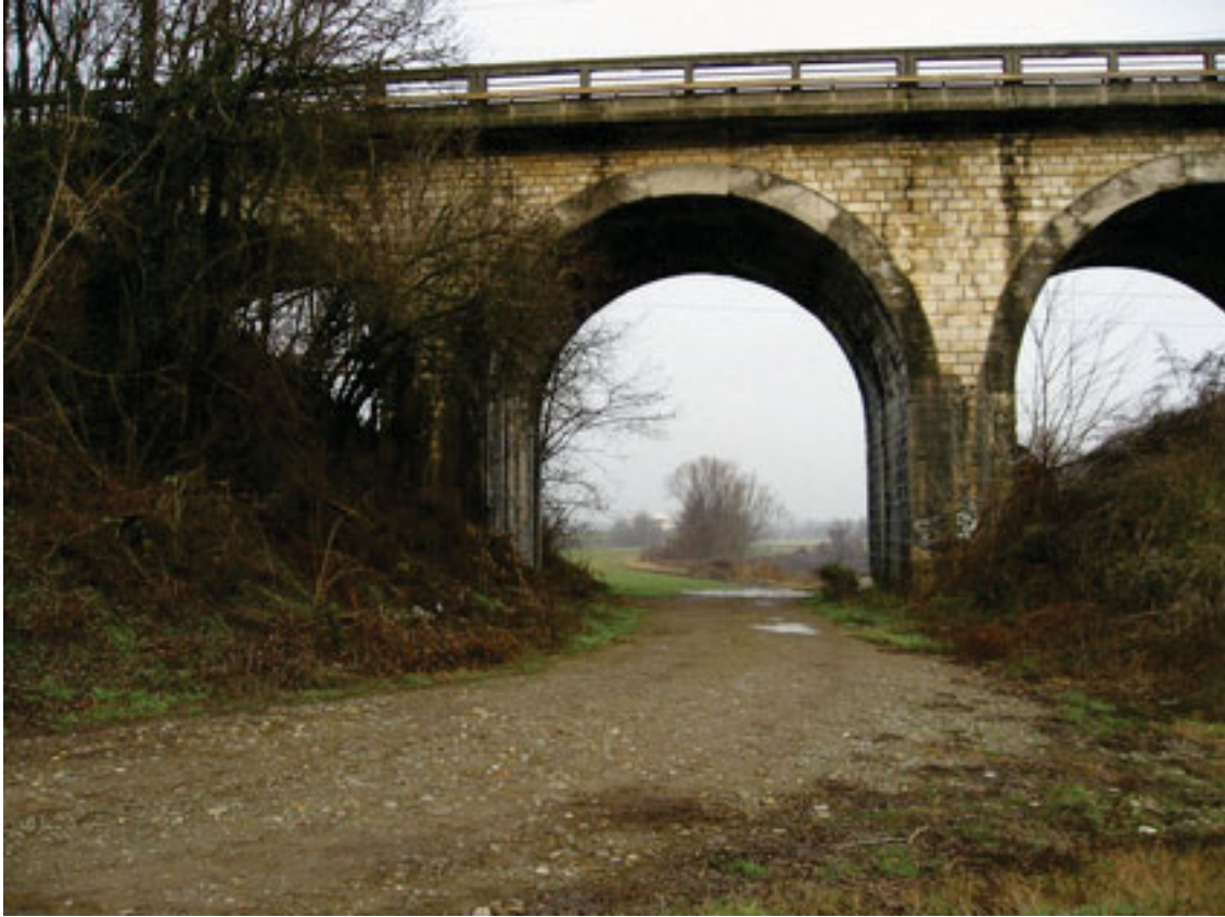
Il ponte della ferrovia MI-VE
