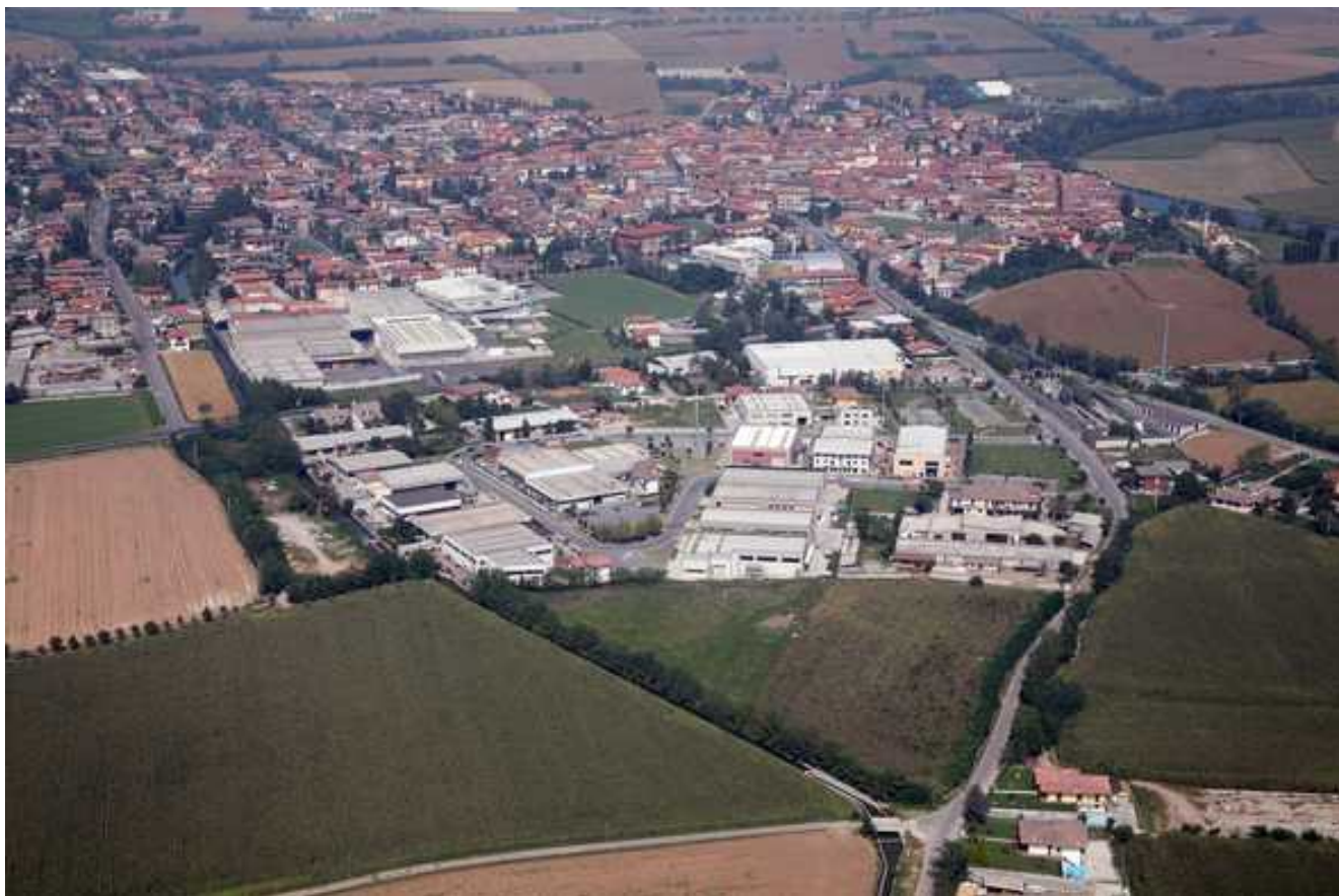
Veduta Aerea - Zona Artigianale
