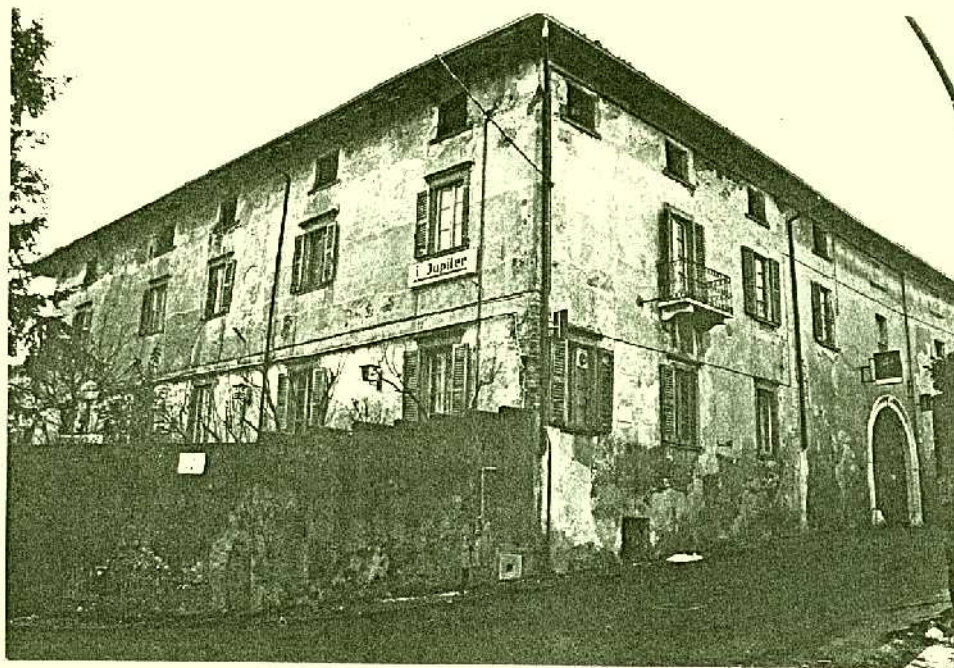
6) edificio n. 25 via XXV Aprile
