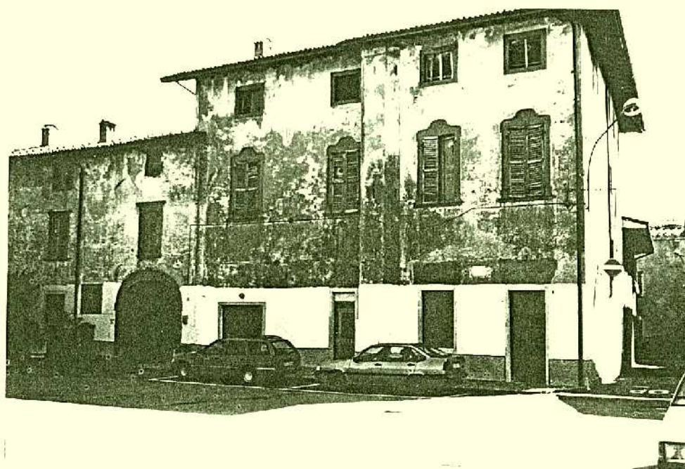
7) edificio n. 139 piazza Castello
