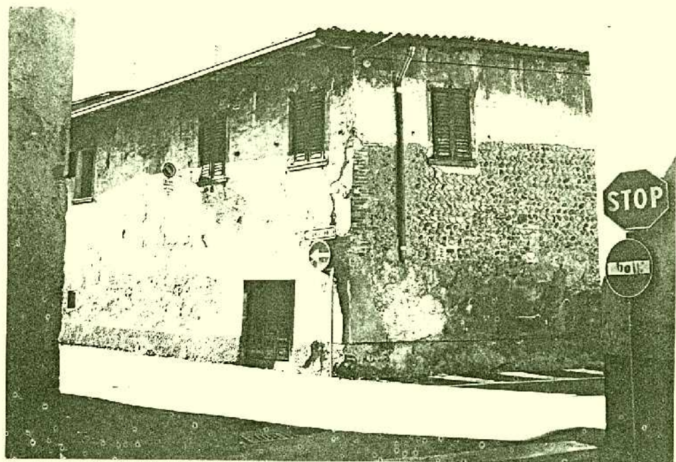
2) edificio n. 87 via Vavassori angolo via San Nicolò
