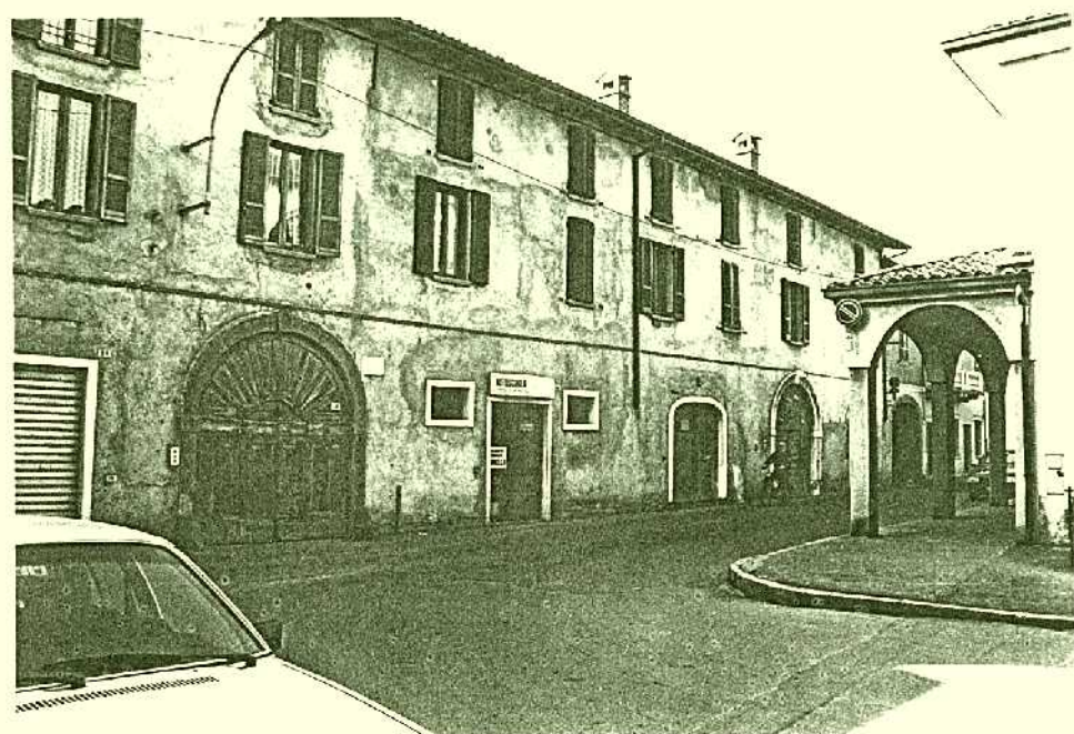
11) edificio 155 via Roma
