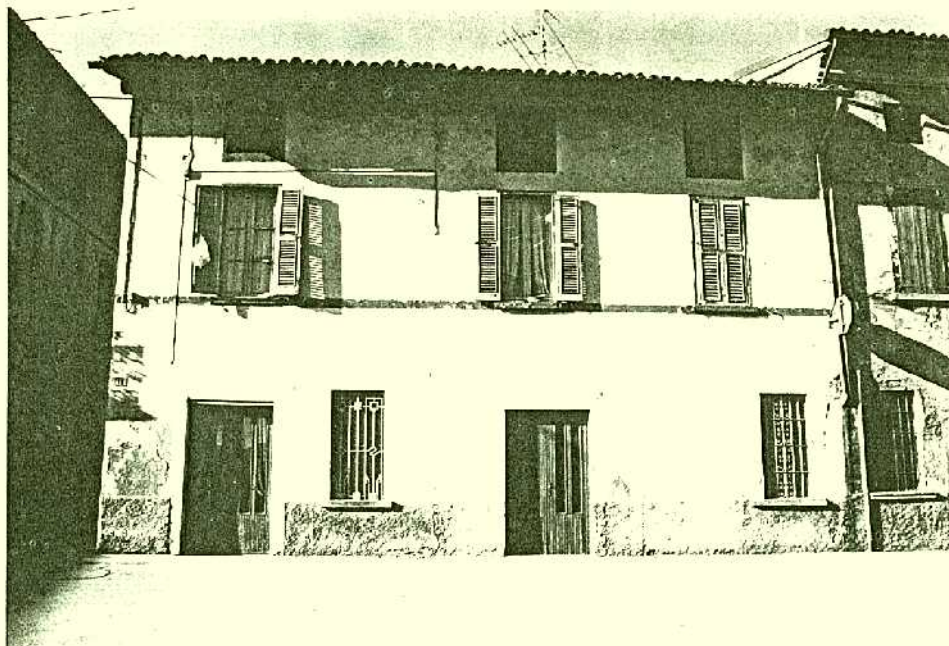
9) edificio 113 via Balestra 15
