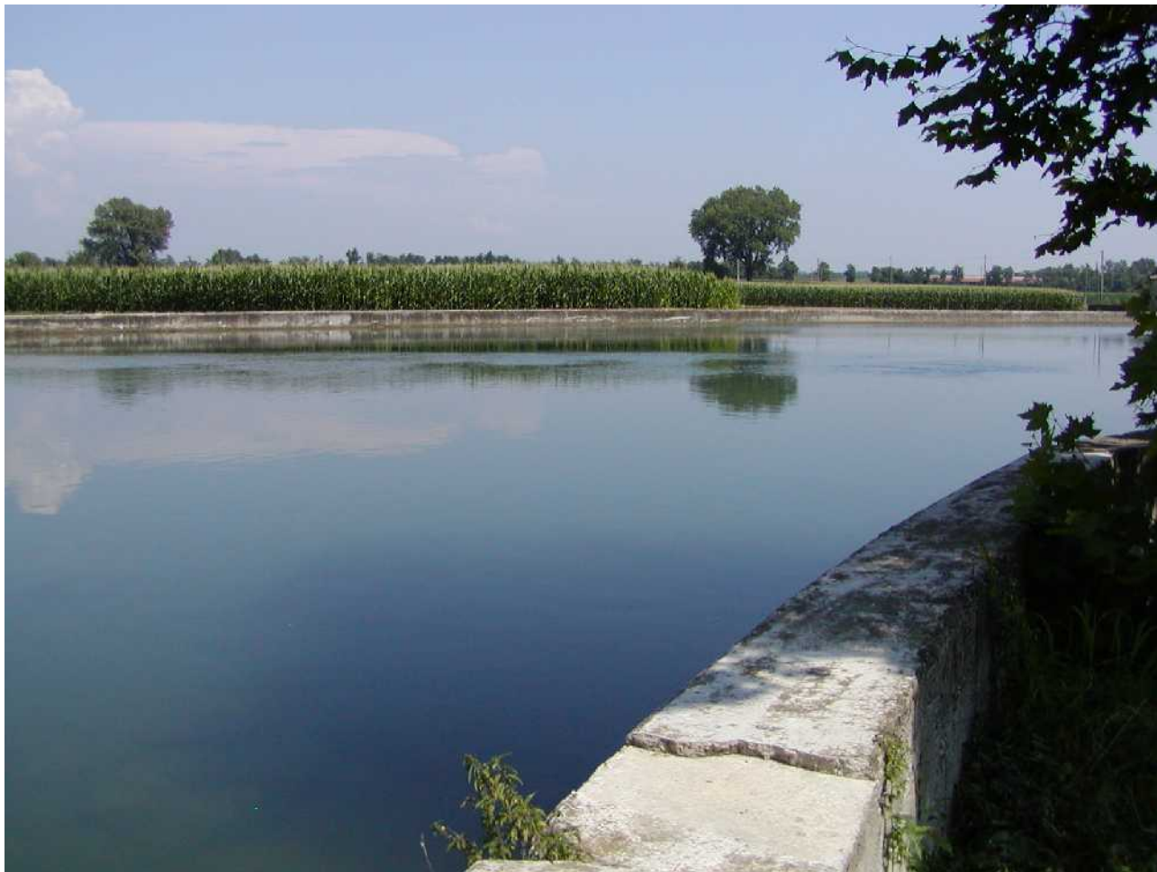
Cividate al Piano-sbarramento del fiume Oglio
