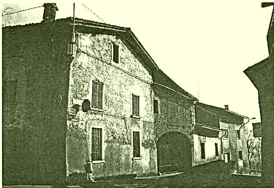
3) edificio n 203 via Ospedale angolo via Campiveri
