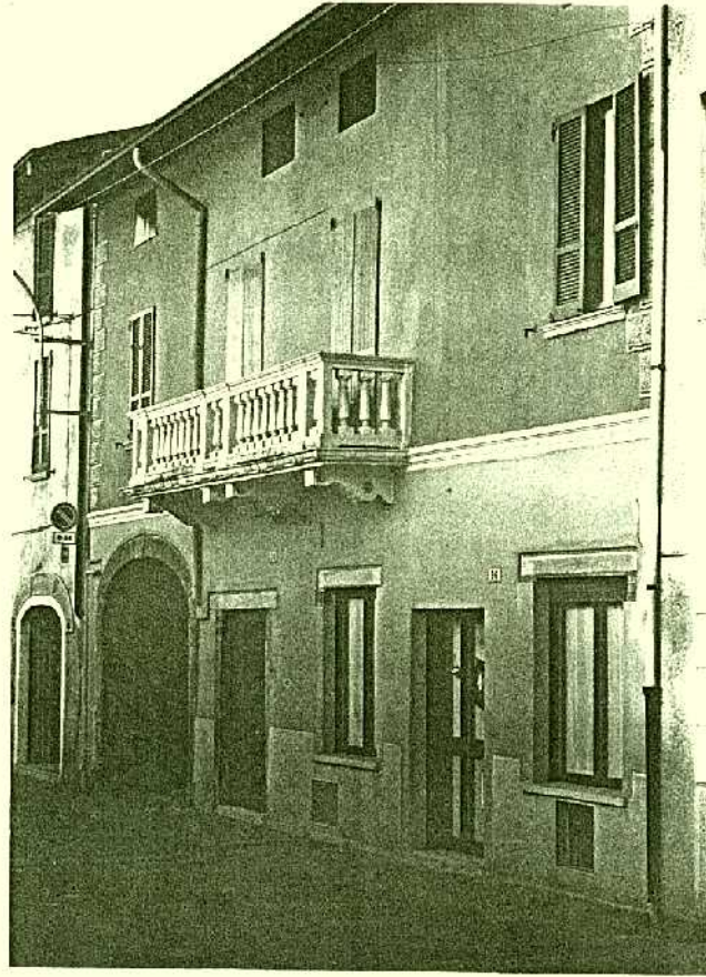
12) edificio 154 via Roma
