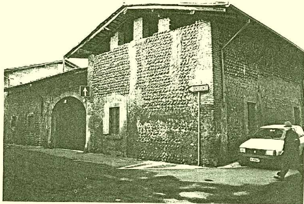
1) edificio n. 153 via Trieste angolo via San Rocco
