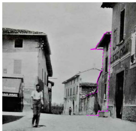
a destra il fronte ovest di Casa Gorini verso il 1955
